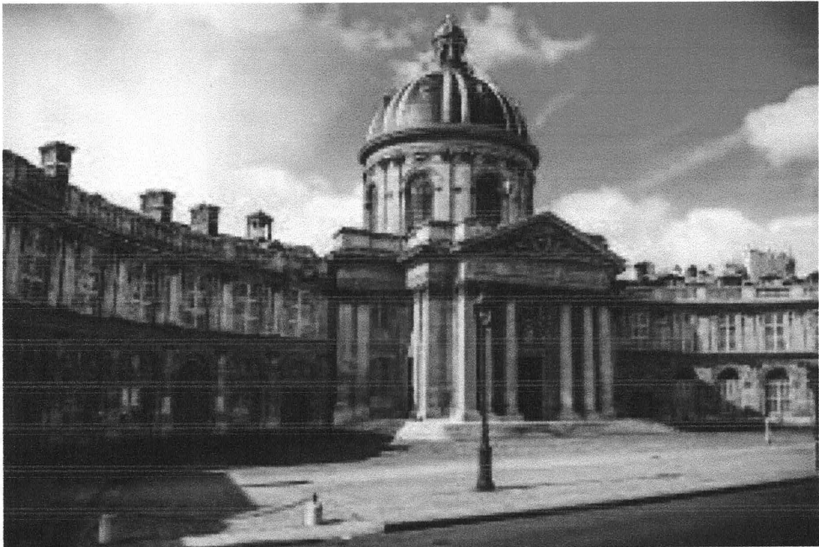
Entrada principal de biblioteca Mazarino
