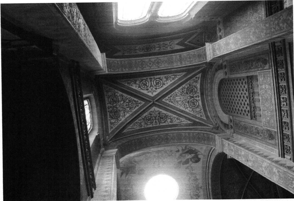
Ilustración 6 Bóveda en Transepto
