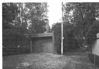
Zona de aproximación peatonal y vehicular
