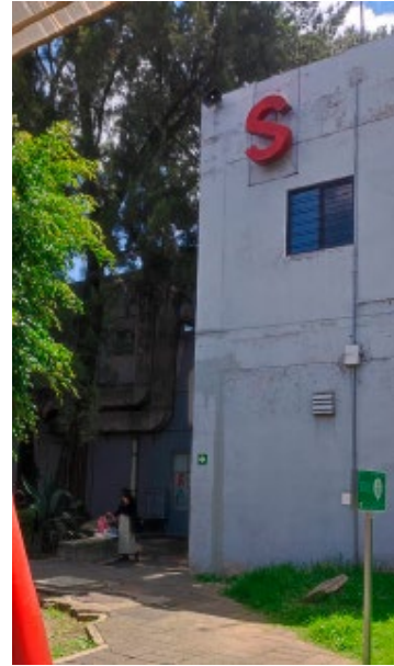
Imagen 4. Identificación de los edificios por letras.
